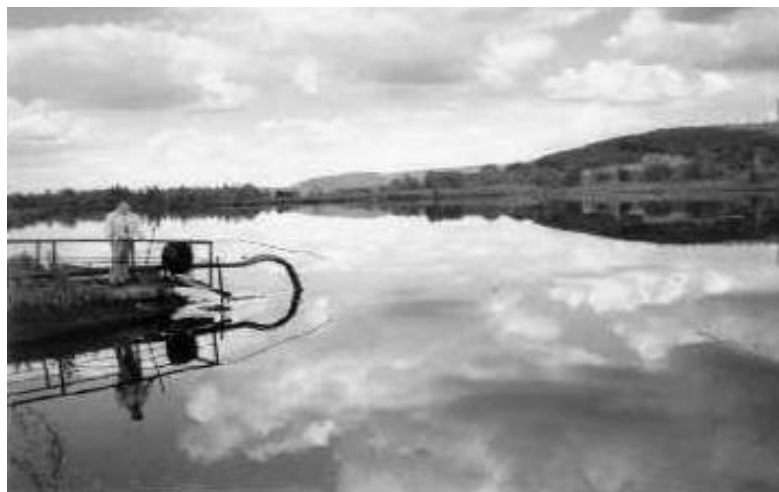
Abb. 1: Abwasserteich des Erdölverarbeitungswerkes Ufa, ein passiver anaerober Bioreaktor
